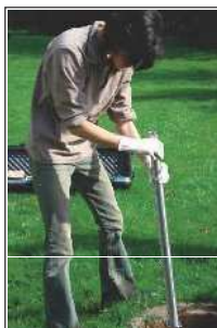
Mise en service d'un ANC existant
