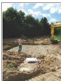
Contrôle d'un ANC (nouveau) sur chantier
