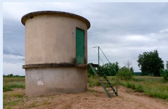
Les premières phases des PGSSE concernent les captages
