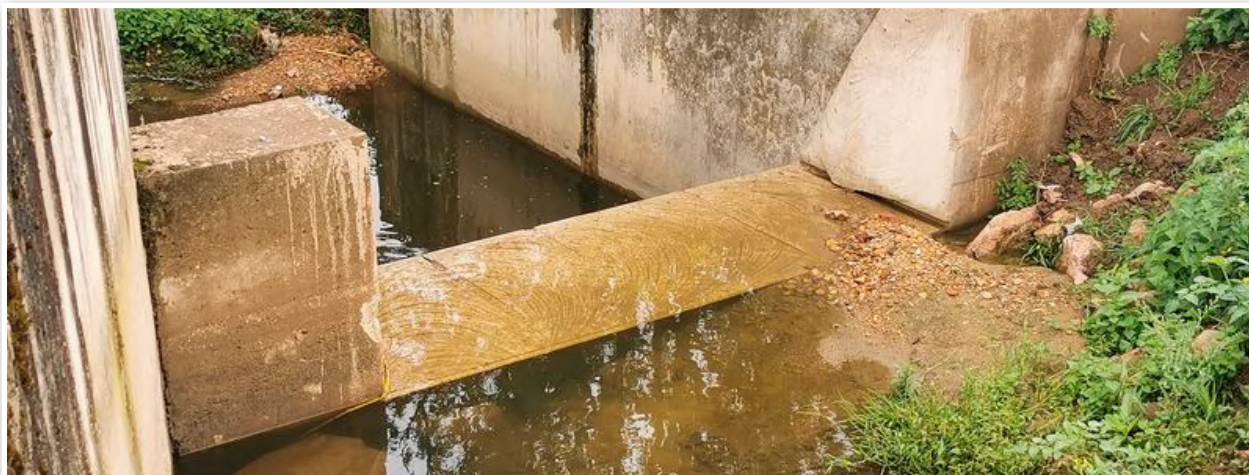
Arasement du déversoir sur le Mardasson à Marcigny
