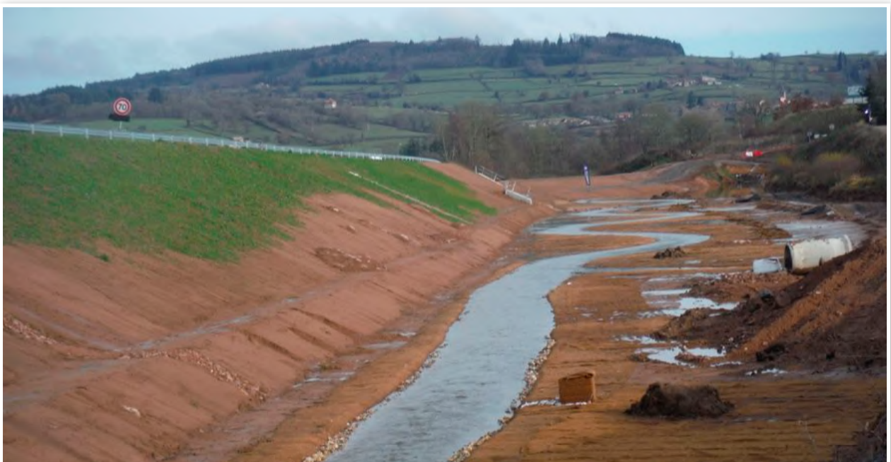
Travaux de reméandrage de la Noue à Trivy
