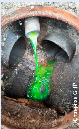
Traçage au colorant lors d'un contrôle de branchement
