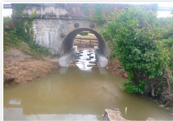
Restoration de la continuité au pont de Poisson sur la RD34 : avant et après travaux
