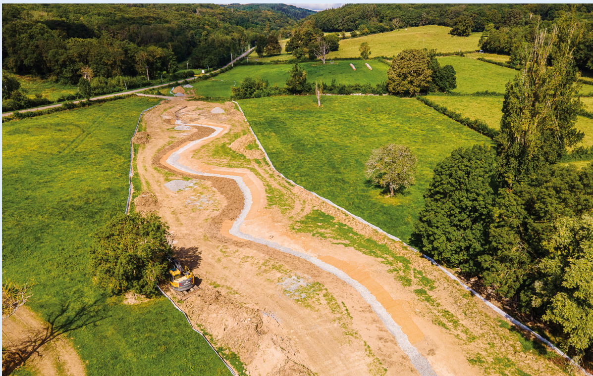
Vue d'ensemble des travaux
